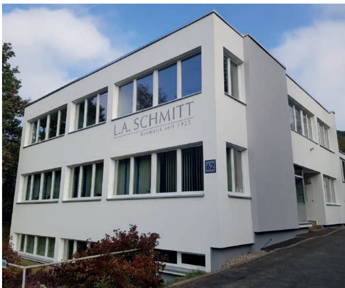
Das Verwaltungsgebäude nach der Sanierung
